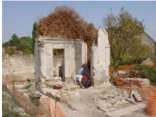
Fig. 13 : vue de la chapelle lors de son dégagement en 2004 (photo. Olivier Blin).
