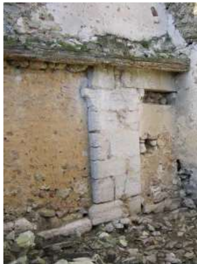
Fig. 11 a et b : ouvertures du premier état avec linteau en bâtière et ouverture double du même type noyée dans les bouchages et réaménagements du bâtiment au cours du temps (photos. Olivier Blin).
